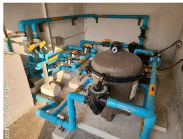
ภาพที่ 1-4 ระบบน้ำใช้
